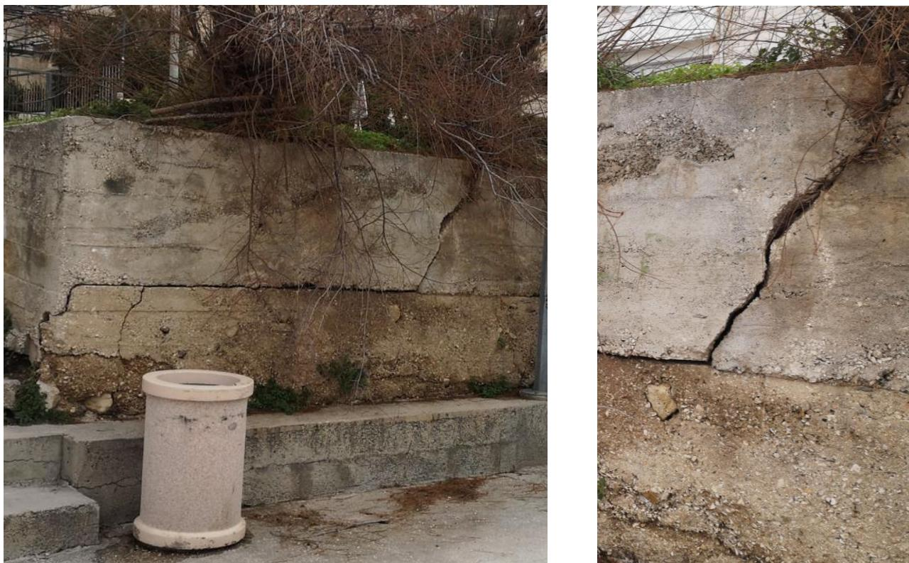
Slika 3: Pukotina na postojećem potpornom zidu
