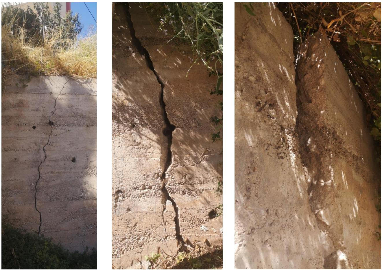
Slika 4: Pukotine na sjevernom dijelu potpornog zida
